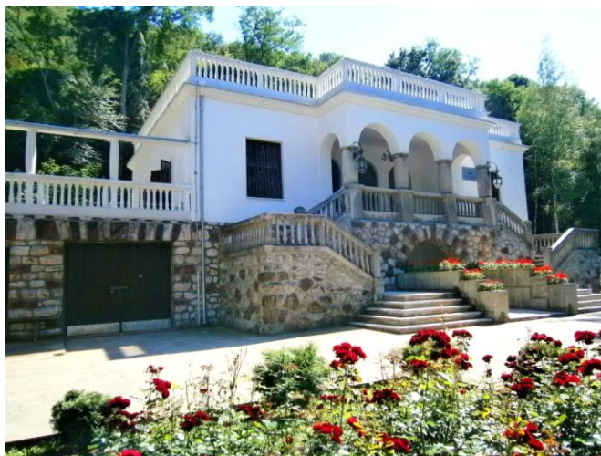
Почивна станция Радон
